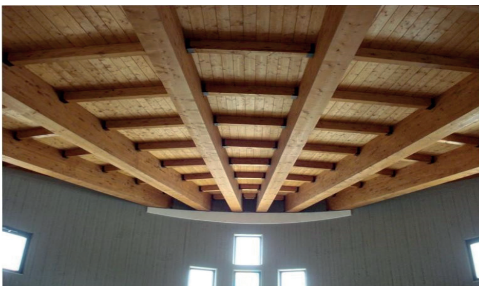
(Copertura in legno lamellare simile alla proposta)
