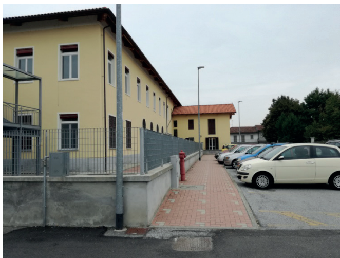
Corpo di fabbrica e parcheggio lato est
