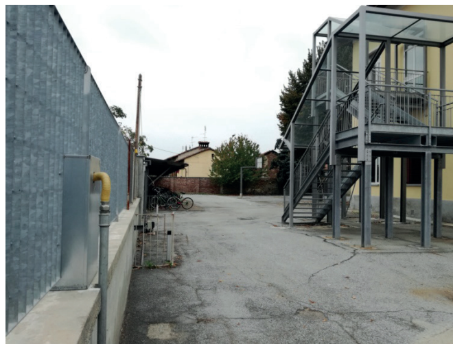
Vista cortile - ingresso lato sud
