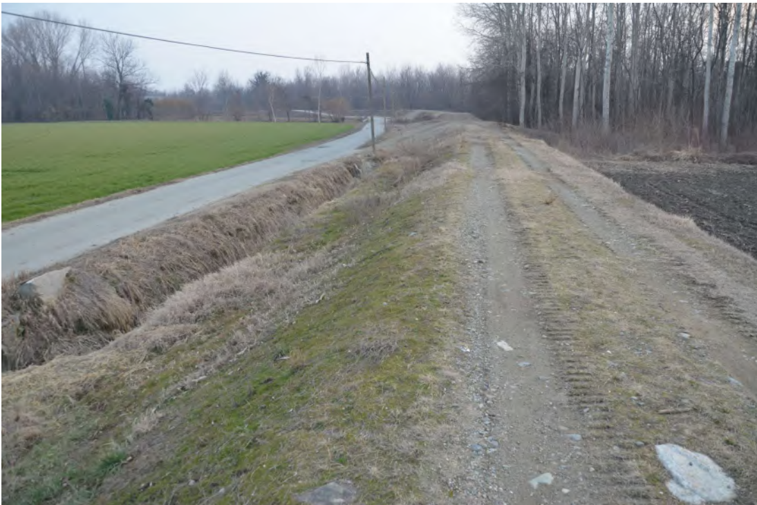
Figura 6 - Argine Baudenasca, loc. Agnesini.
