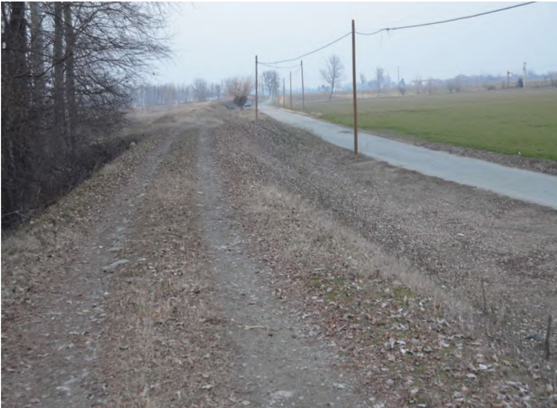
Figura 5 - Argine Baudenasca, loc. Agnesini.
