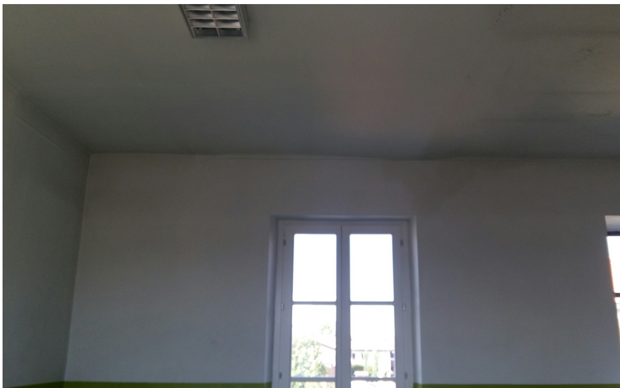
Figura 10 - Solaio di copertura dell'aula di musica
