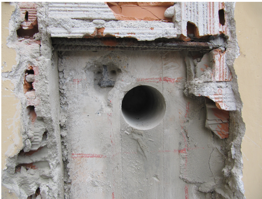
Figura 26 - Particolare estrazione carota CP5 Corpo B
