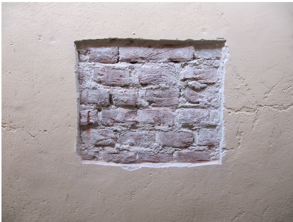
Figura 30 - Muratura portante Corpo D
