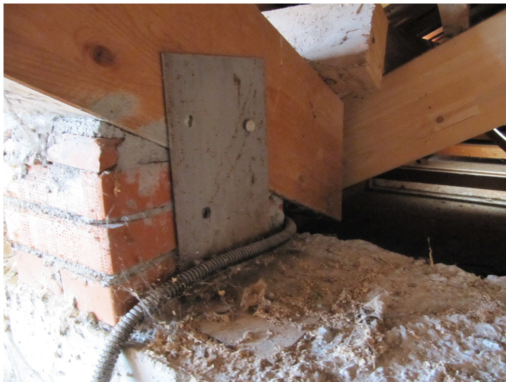
Figura 23 - Particolare connessione acciaio-legno
