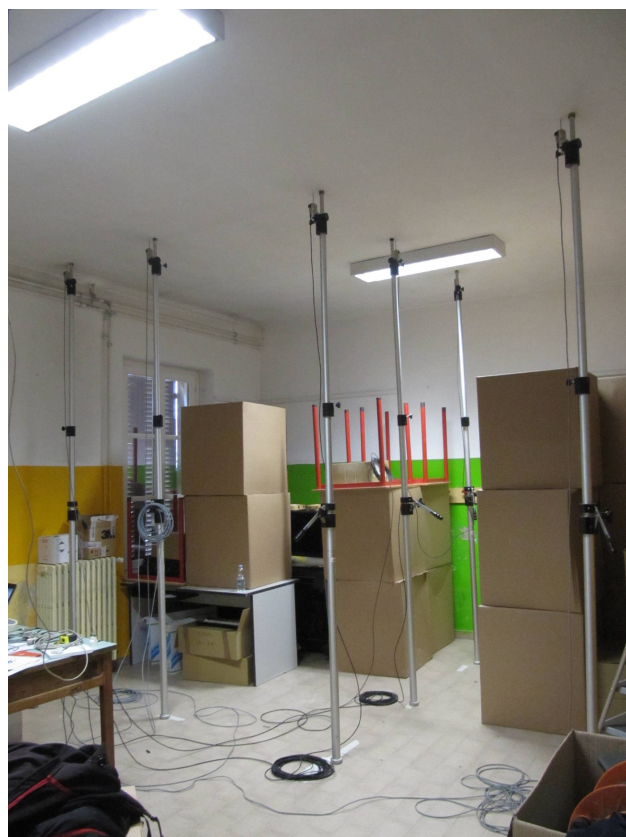
Figura 33 - Particolare disposizione estensimetri prova di carico su solai in putrelle e tavelloni Corpo D
