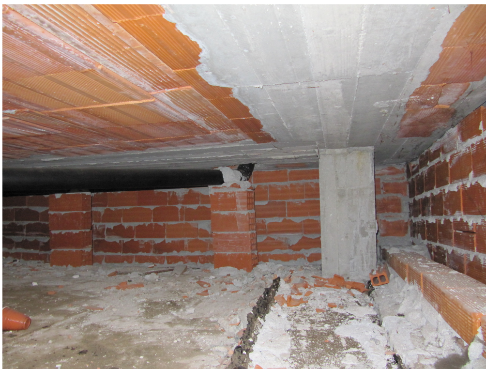
Figura 27 - Solaio “a perdere” Corpo B
