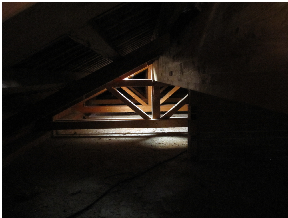
Figura 24 - Struttura di copertura in legno del corpo D
