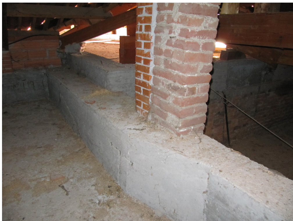
Figura 19 - Particolare pilastri in mattoni in appoggio sui cordoli a sostegno della copertura
