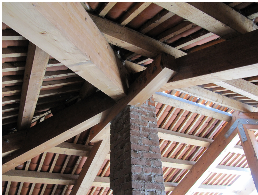
Figura 18 - Particolare appoggio travi di copertura in legno su pilastri in mattoni
