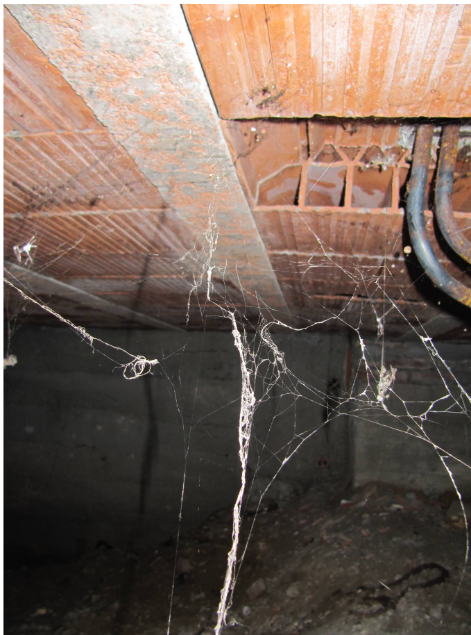
Figura 5 - Vista intradosso del solaio di calpestio degli spogliatoi
