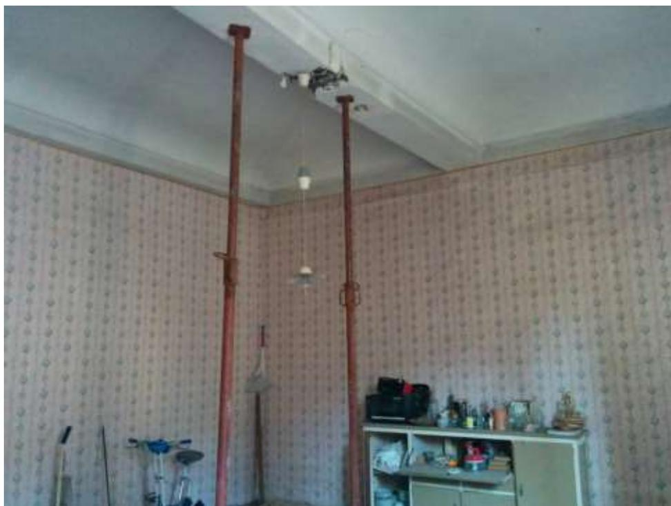
Foto "F" - Vista interna del solaio puntellato.
