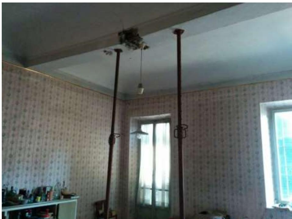
Foto "E" – vista interna del solaio puntellato.
