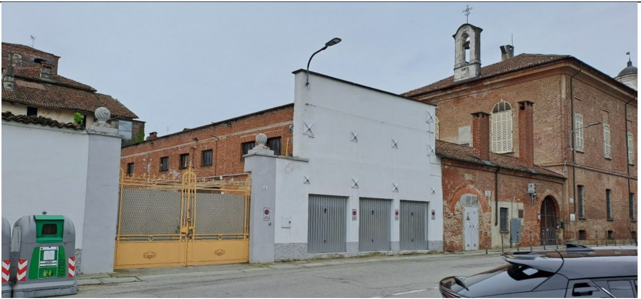
Fotografia dell'area SC4 vista da via Ospedale
