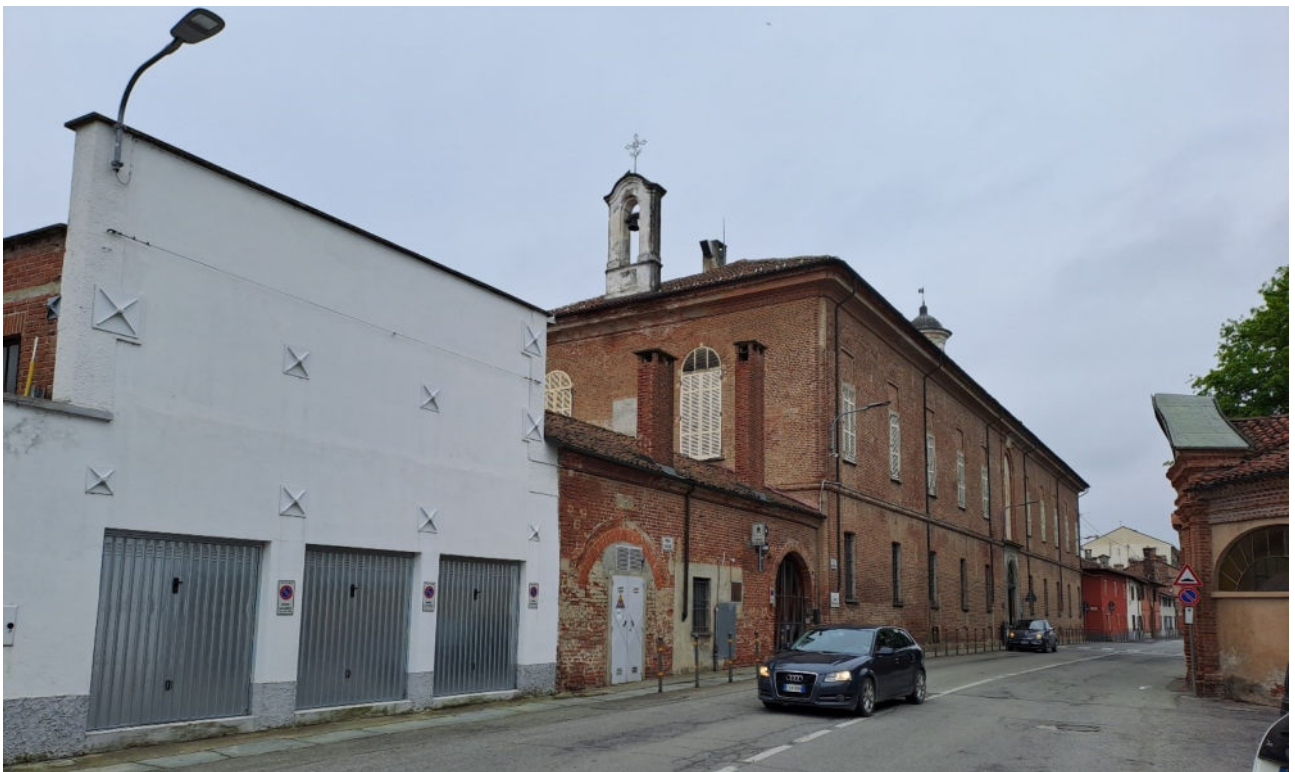
Fotografia dell'area SC4 vista da via Ospedale
