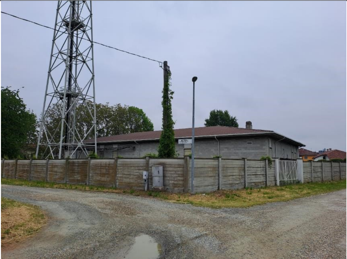
Fotografia dell'area S19 vista da via Nino Buffa
