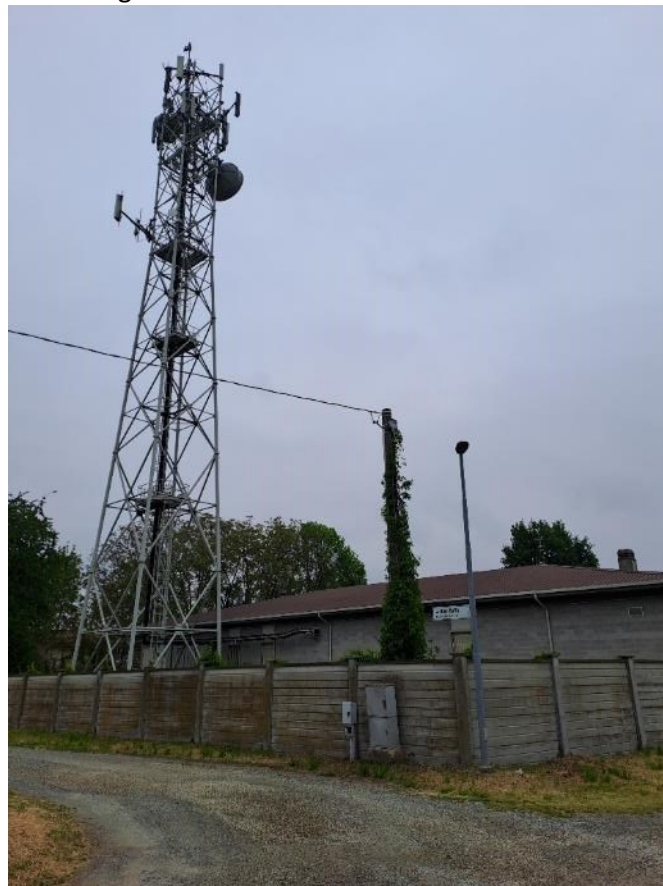
Fotografia dell'area S19 vista da via Nino Buffa
