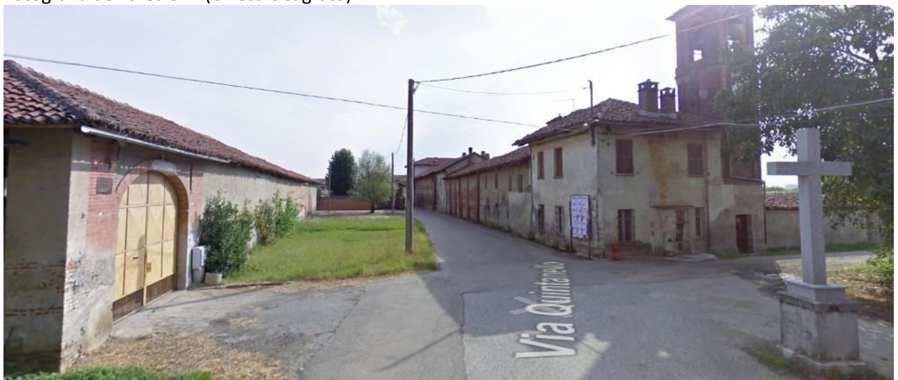
Fotografia dell'area SR2 (viabilità e aree per servizi indicate dal PRGC a lato della viabilità)
