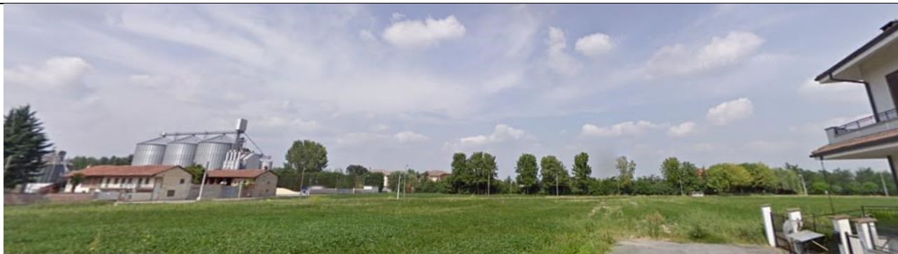
Fotografia dell'area da via Marconi
