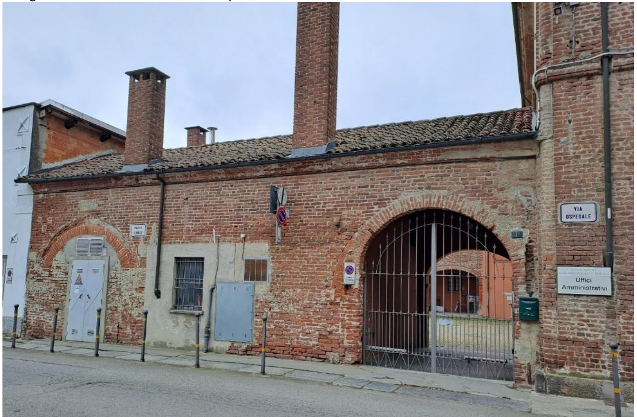
Fotografia dell'area SC4 vista da via Ospedale
