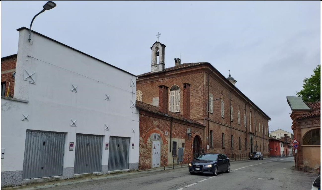
Fotografia dell'area SC4 vista da via Ospedale
