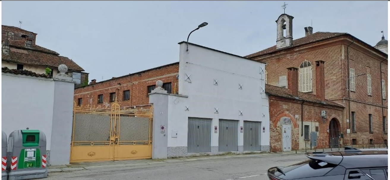
Fotografia dell'area SC4 vista da via Ospedale
