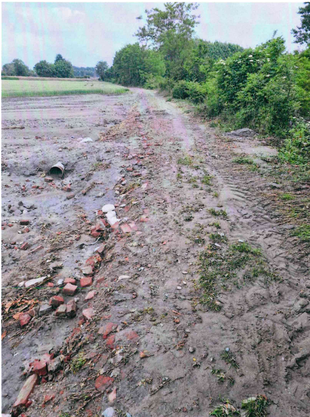
FOTO 4 – LOCALITA' "FONTANETTE" Strada comunale detta "Via antica di Piovascso"
