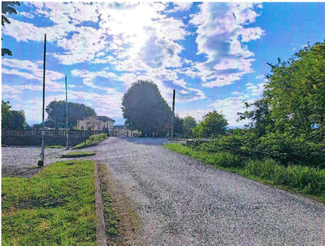
FOTO 1 – LOCALITA' PARCHEGGIO CIMITERO COMUNALE Vista da ovest situazione ante evento alluvionale (Anno 2022)
